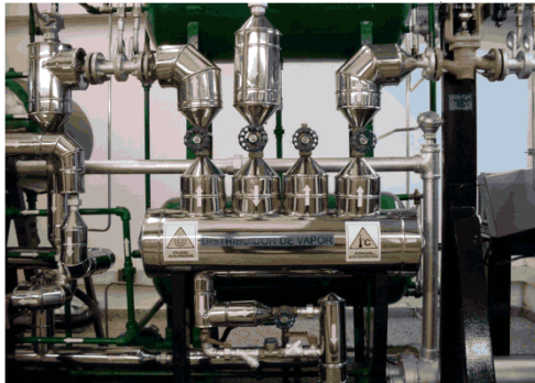
Figura 9. Distribuidor de vapor.
