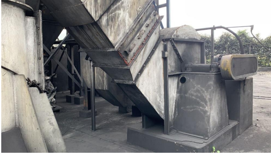
Ilustración 10: Ventilador tiro forzado
