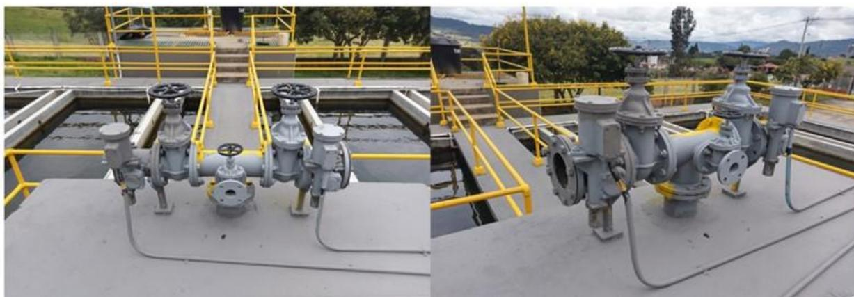
*Ilustración 19 Cubillos A, Estructura de la válvula rompe vacío, Cogua 2015 Archivo de autoría de EAAAZ*
