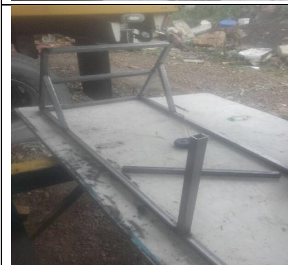
Figura 11. Proceso de ensamble del prototipo mediante soldadura eléctrica 6013
