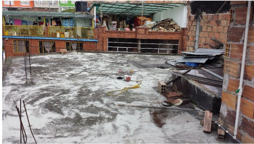
Figura 33. Área de instalación de módulos.
