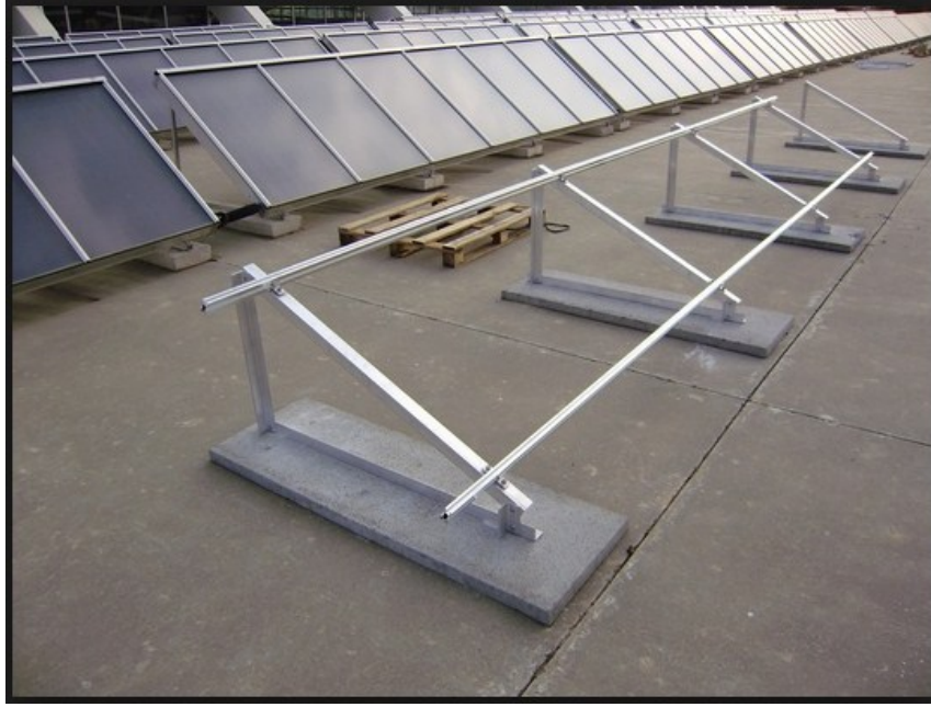
Figura 34. Estructura de los módulos.
