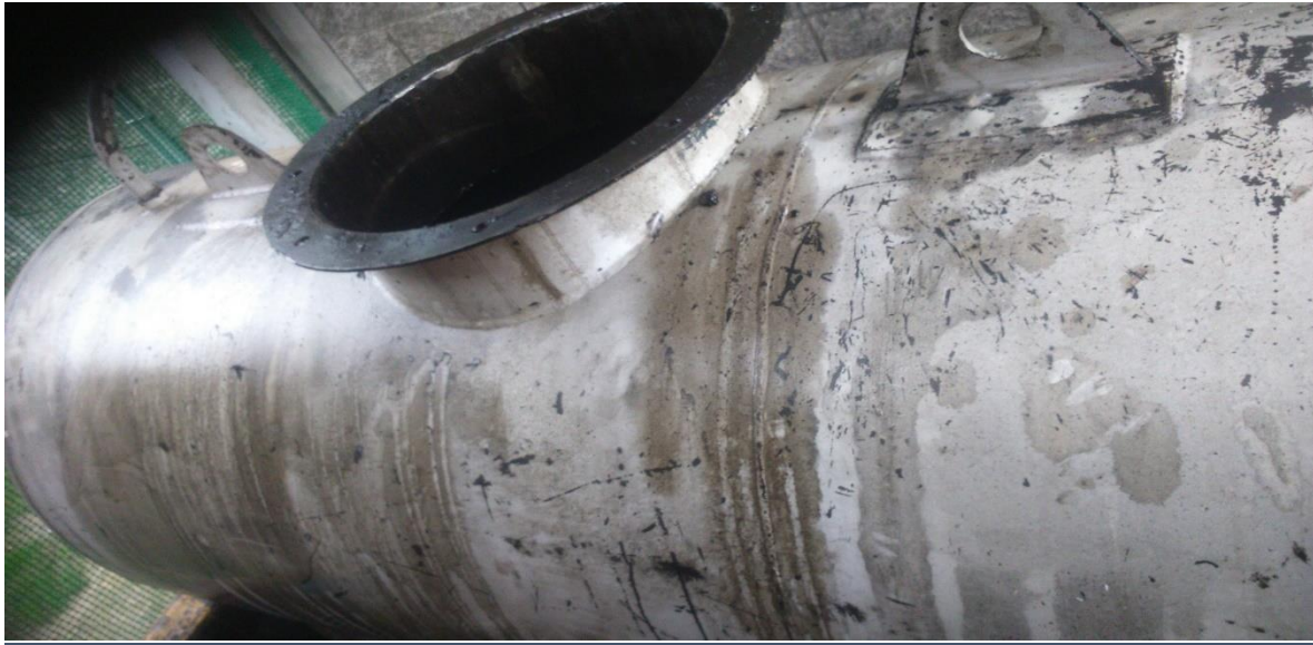
figura 15 estado depósito para almacenar el aceite usado -lubricación de vehículos
