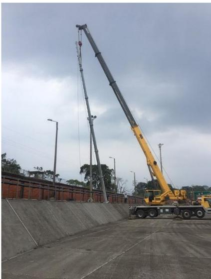
Figura 12. Izaje crítico con grúa telescópica para postes de 26 m de altura.
