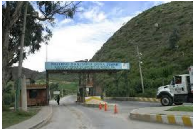
Ilustración 10 Relleno Sanitario Doña Juana
