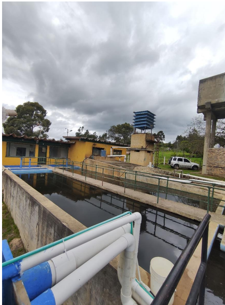
Visita planta de tratamiento de agua potable llanitos, fuente: autor
