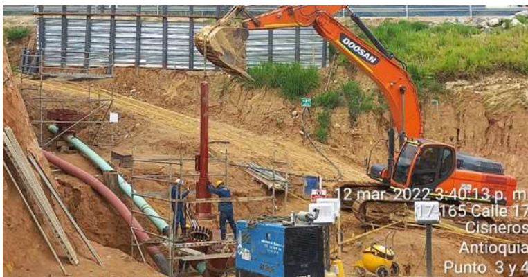
Montaje de perforadora Hot tapping
