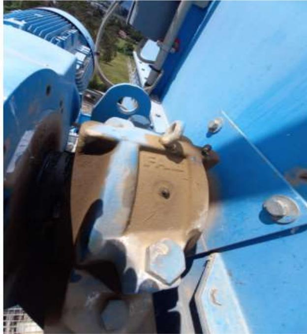
*Figura 30 rodamiento rueda dentada segmentada lado motorreductor*
