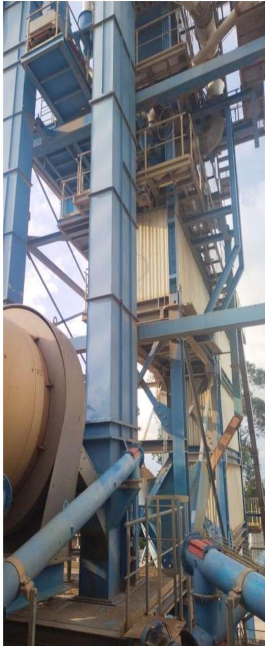
En la figura 7 se presenta el sistema de elevación por cangilones, la cual, su función es realizar el transporte de material a una zona elevada luego para pasar por la criba para seleccionar el tamaño del agregado.
