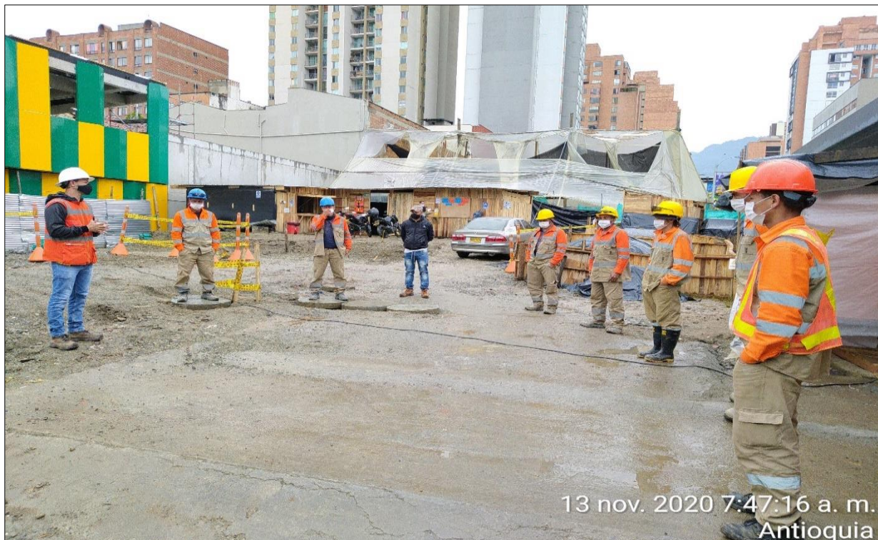
Figura 12: Capacitación en obra - Evidencia 1 (Autoría propia).
