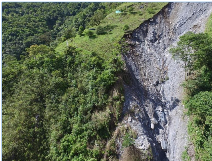
Ilustración 16 Fotografía Dron Km 64
