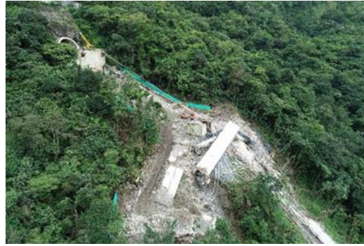
Ilustración 7. Colapso Pila B del puente
