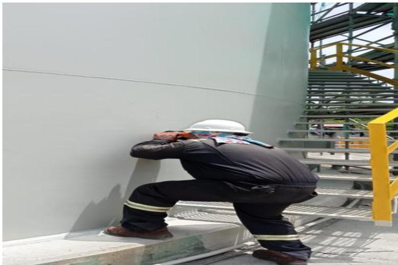
El inspector técnico midiendo la verticalidad con plomada óptica. Debe estar pegada al tanque vertical, lo que conlleva riesgo térmico (las paredes del tanque manejan temperaturas mayores de 40°C), puede caerle el carro magnético o elementos de protección del inspector que está arriba del tanque.
