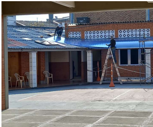
Imagen 1. Trabajo en alturas
