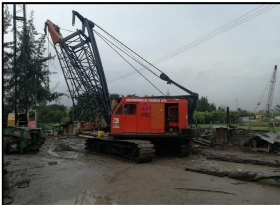
Grúa sobre Orugas 003 (GSO – 003)
