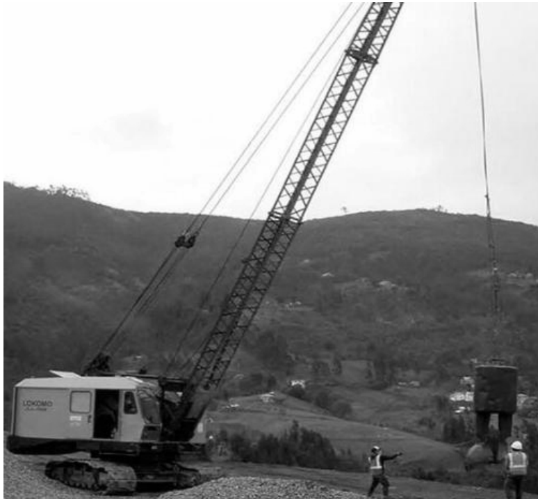
Ilustración 1: Lokomo JLL 1600 trabajando en Guayaquil, Ecuador (Fuente: Cimentaciones de Colombia S.A.S).
