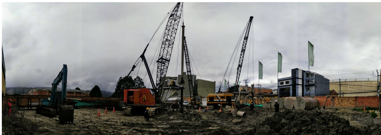
Ilustración 3: Link Belt LS 118 dentro del proyecto Torem al norte de la ciudad de Bogotá (Fuente: Propia).
