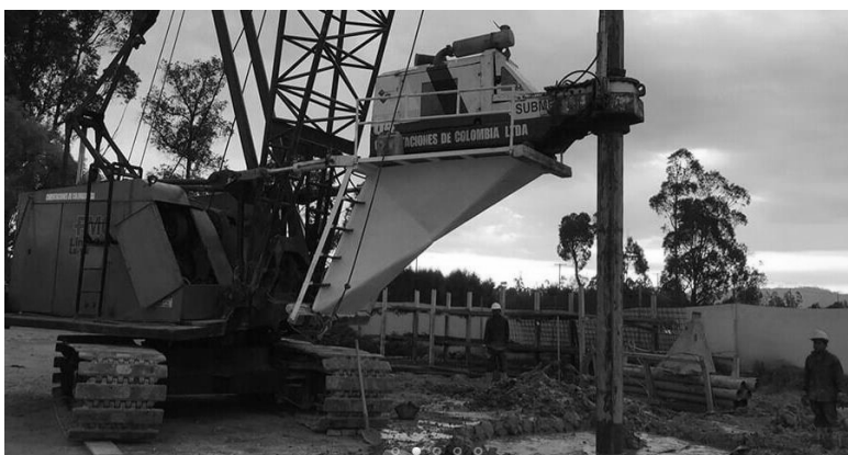
Ilustración 2: Piloteadora Link Belt LS 118 en Madrid, Cundinamarca (Fuente: Cimentaciones de Colombia S.A.S).
