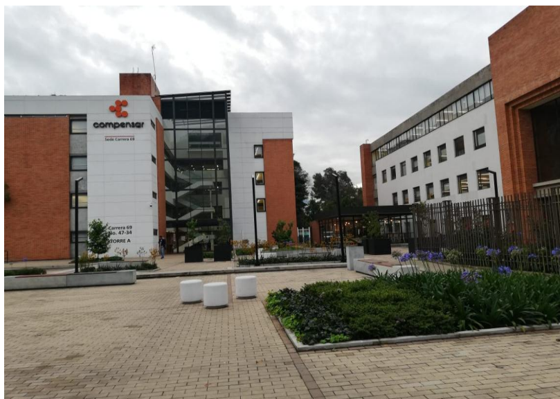
Figura 1 fachada Consorcio Salud
