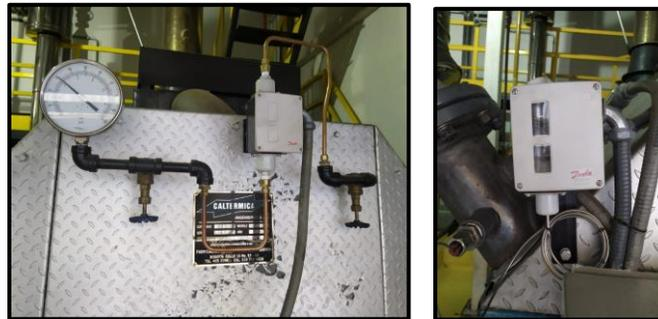
*Figura 8: Termostato - Manómetro de temperatura*
