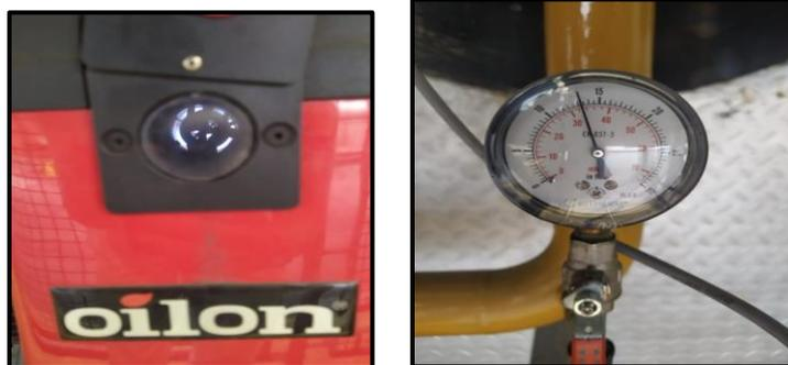
*Figura 19: Llama encendida – Manómetro entrada ACPM (10-20PSI)*
