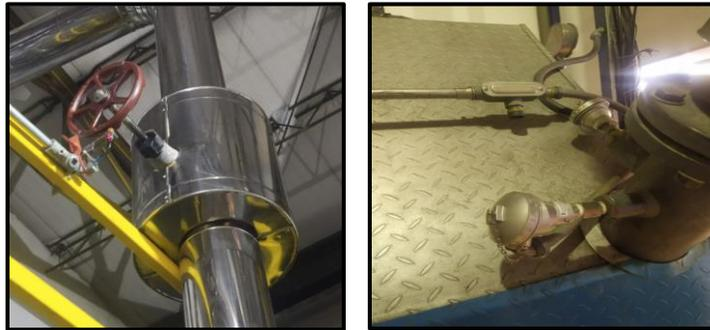
*Figura 10: Válvula de entrada Aceite Térmico – Sensor de temperatura PT 100 #2*
