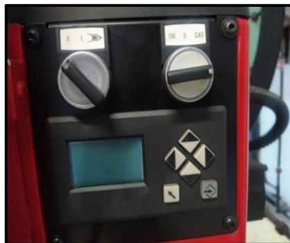
*Figura 17: Pantalla de control quemador*
