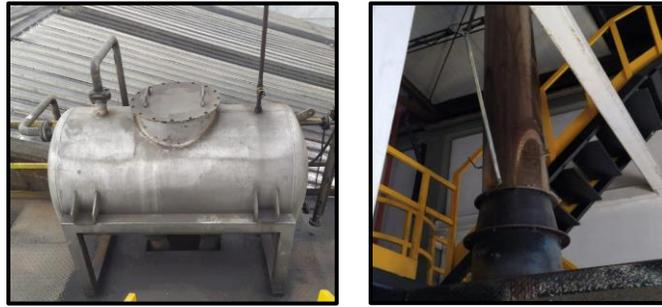
*Figura 12: Tanque de Expansión – Chimenea salida de gases*
