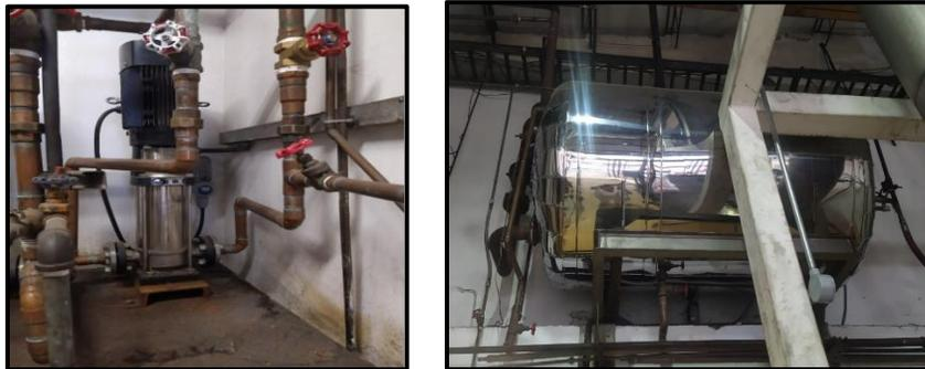
*Figura 38: Bomba de agua – Tanque de almacenamiento*
