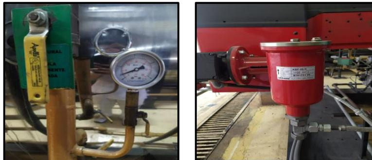
*Figura 36: Manómetro entrada Gas – Filtro de ACPM*
