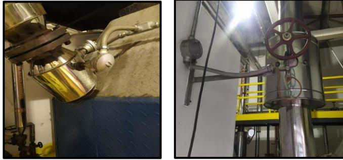
*Figura 9: Sensor de temperatura PT 100 #1 – Válvula de salida de Aceite Térmico*
