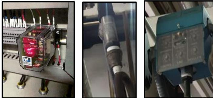
*Figura 32: Switch de bajo nivel de agua – Transmisor de presión – Controlador presión*
