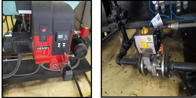
*Figura 34: Quemador Oilon finlandés – Válvula de Purga*
