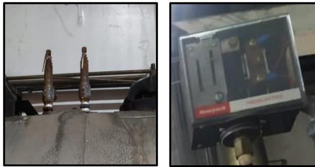
*Figura 31: válvula de seguridad – Presostato de vapor*
