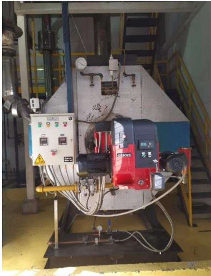
*Figura 6: Caldera de aceite térmico CALTERMICA 100BHP*
