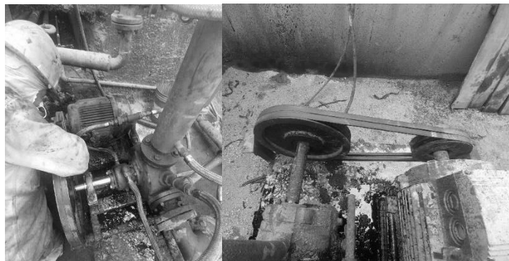
Figura 9 Cambio de correas bomba de asfalto
