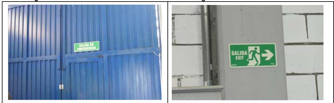
Figura 22 Fotografías de señalización de las salidas de emergencia
