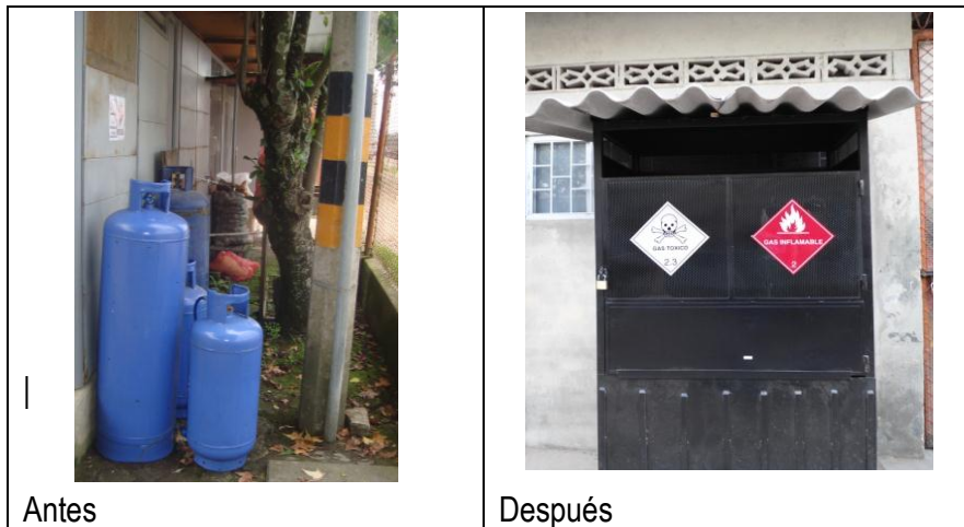
Figura 16. Fotografía Sitio de Almacenamiento de Gases antes y después
