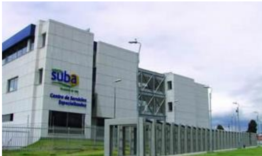
Fotografía 1. Instalación del Hospital de Suba (Centro de servicios especializados).
