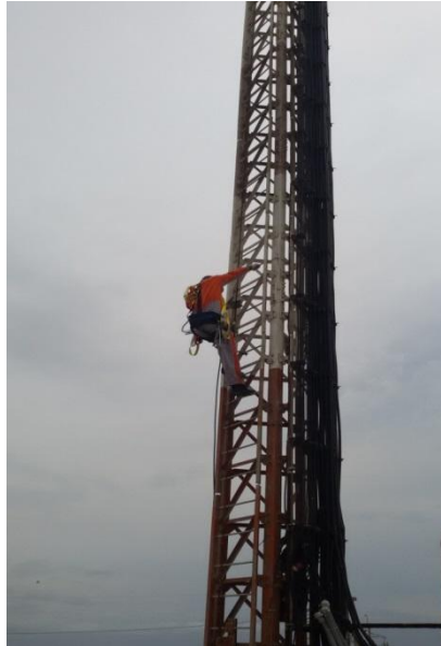
Ilustración 14. Desplazamiento #2 del trabajador en la estructura
