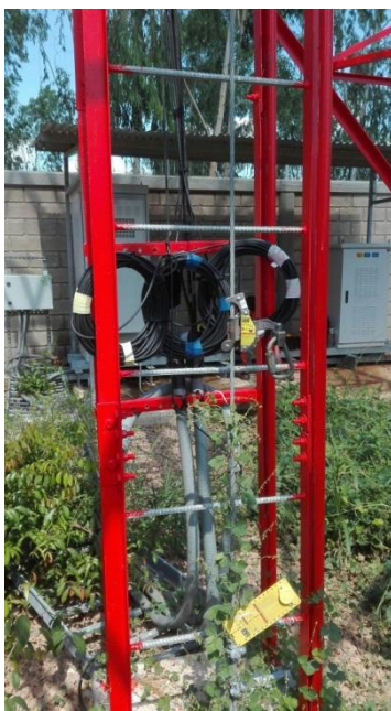
Ilustración 5. Arrastrador de freno anti caídas
