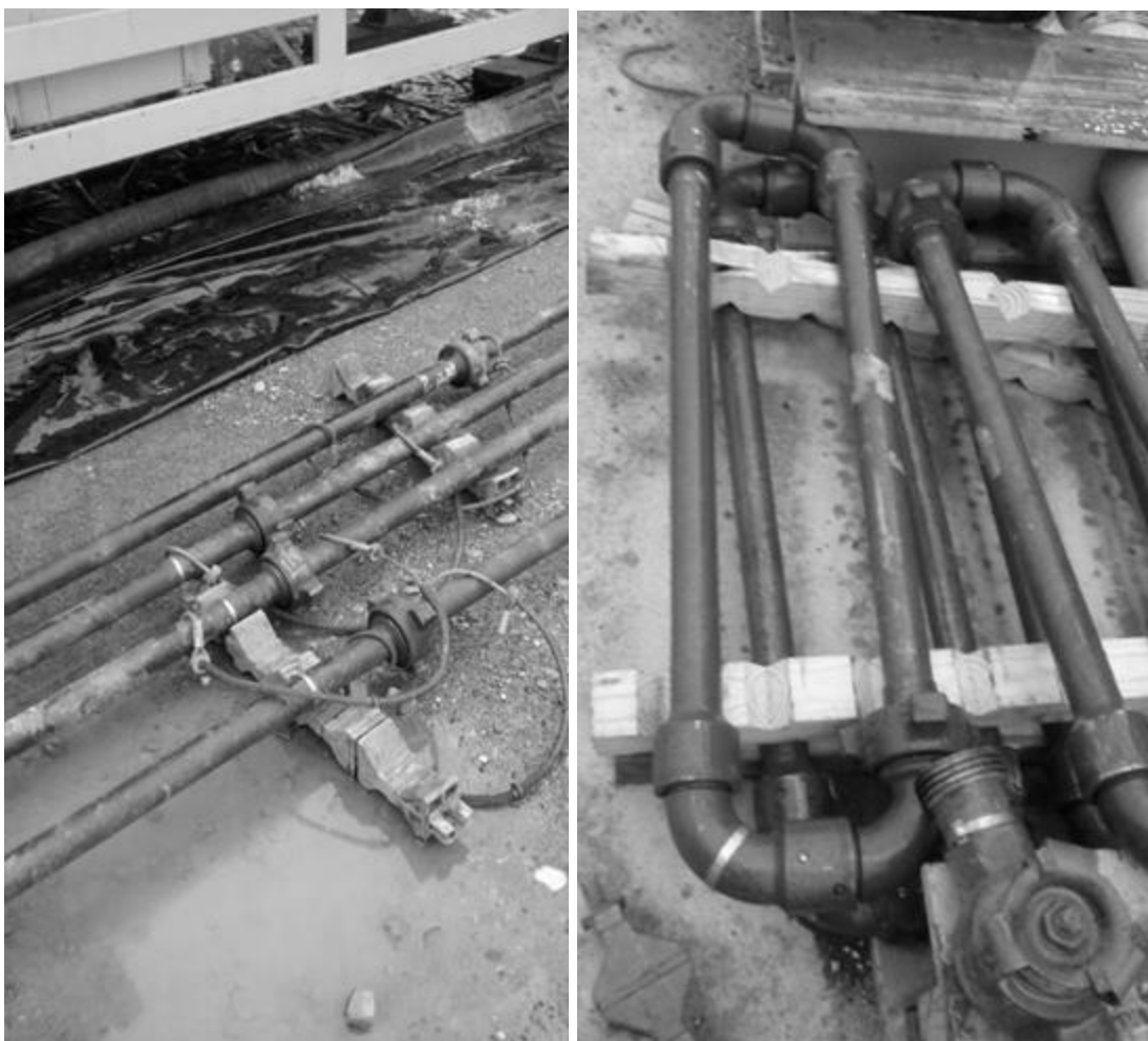
Figura No. 19. Detalle tendido tuberías alta presión
