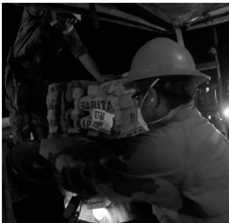
Figura No. 29. Vaciado manual de sacos de Barita para mezcla
