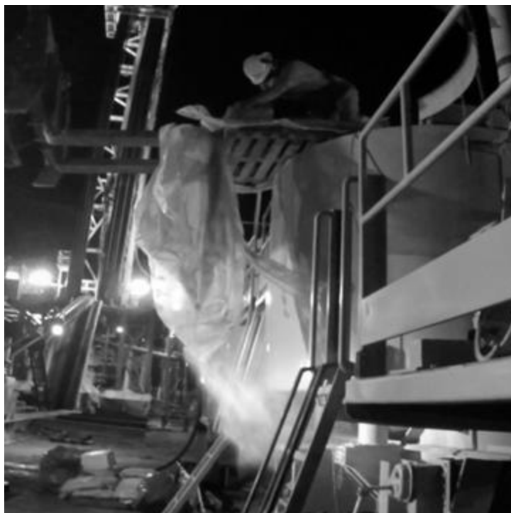
Figura No. 28. Vaciado de Sacos en tanque de mezcla.
