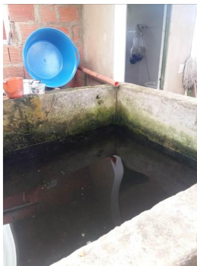
Ilustración 16. Sistema de recolección de agua lluvia
