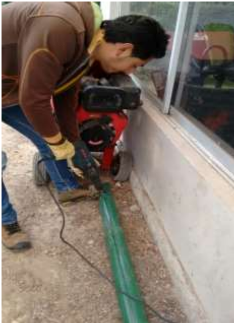
Ilustración 31. Perforación tubo con taladro. Fuente: Autor
