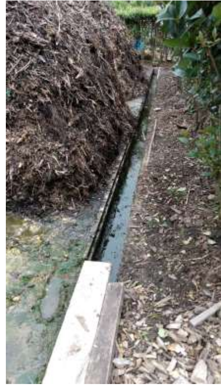
Ilustración 79. Canal de lixiviados tapada. Fuente: Autor
