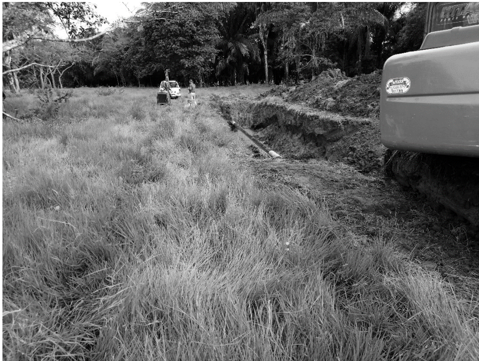
Imagen 3. Ingreso a la zona de trabajo.
