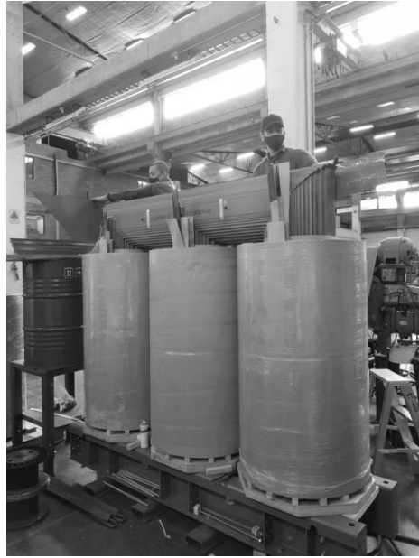
Imagen 2. Puesto de trabajo. Ensamble de transformadores
