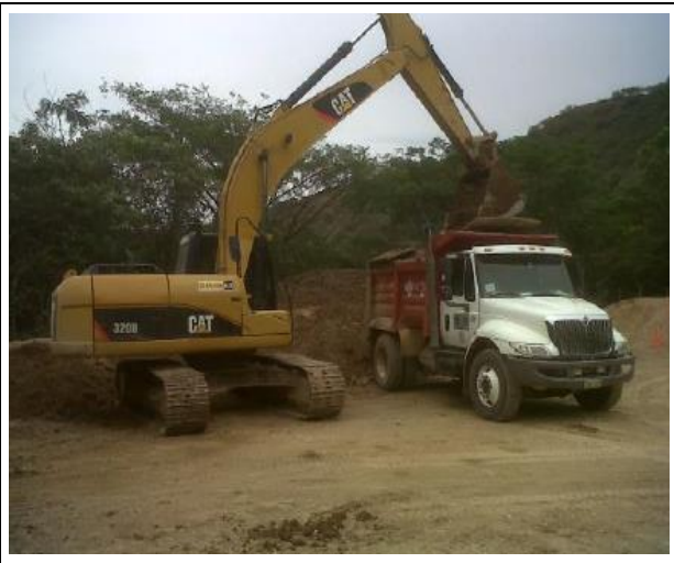
FOTOGRAFIA N°: 50 FECHA: Abril de 2013 LUGAR: Perforación OBSERVACIONES Movilización de los cortes WBM tratados para su disposición final en el zodme 4
