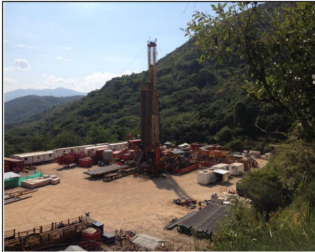
FOTOGRAFIA N°: 1 FECHA: Enero-Febrero de 2013 LUGAR: Perforación OBSERVACION Se observa taladro y locación LH-31
