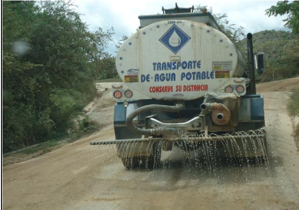
FOTOGRAFIA N°: 45 FECHA: Abril de 2013 LUGAR: Vía OBSERVACIONES Irrigación sobre vía de ARI tratada, LH-34
