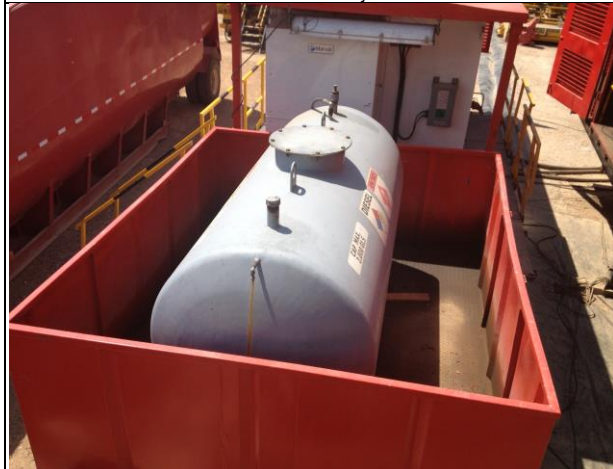
FOTOGRAFIA N°: 3 FECHA: Enero-Febrero de 2013 LUGAR: Perforación OBSERVACION Almacenamiento de ACPM
