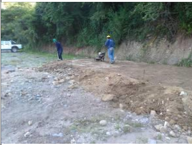
FOTOGRAFIA N°: 53 FECHA: Enero de 2013 LUGAR: Islas campos OBSERVACIONES Compactación para caseta de químicos
