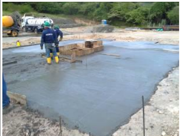
FOTOGRAFIA N°: 54 FECHA: Enero de 2013 LUGAR: Islas campos OBSERVACIONES Fundición placa taladro y vigas patin
