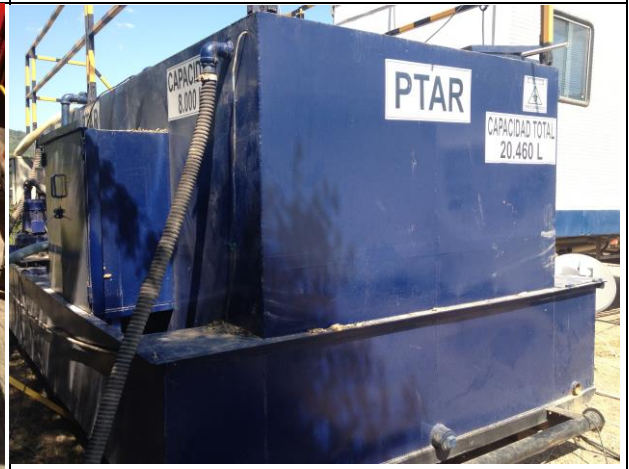
FOTOGRAFIA N°: 4 FECHA: Enero-Febrero de 2013 LUGAR: Perforación OBSERVACION PTAR Minicamp
