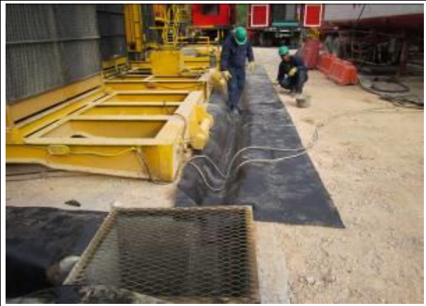
FOTOGRAFIA N°: 52 FECHA: Enero de 2013 LUGAR: Islas campos OBSERVACIONES Instalación de geomembrana
